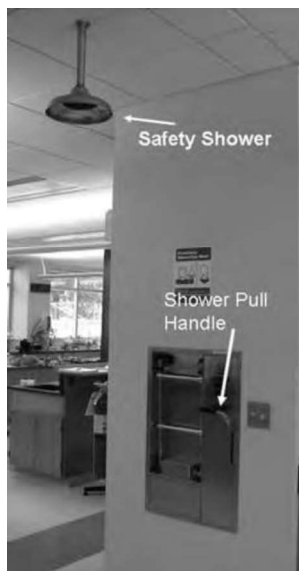
شکل ۳-۱. محل مناسب نصب دوش ایمنی آزمایشگاهی برای استفاده در موارد اورژانسی در کوتاه‌ترین مدت.
