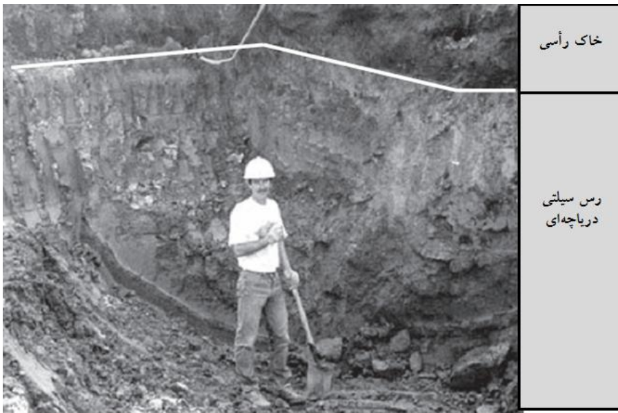
شکل ۵-۶. حفاری در یک سایت ساختمان‌سازی موجب برونزد لایه‌های زمین‌شناسی شده‌است (عکس از راجرز. دیترویت آمریکا، کاوفمن و همکاران، ۲۰۱۱).
