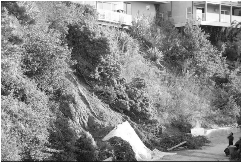
شکل ۴-۲. گسیختگی شیب و ریزش دامنه در یک منطقه مسکونی
