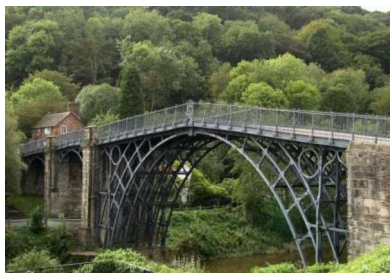
شکل ۱-۱. پل کولبرک دیل - نخستین پل تمام آهنی
