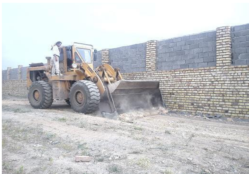
شکل ۱-۳. تسطیح محوطه
