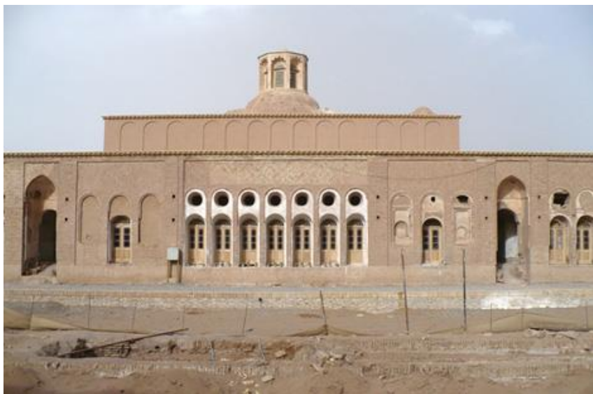
شکل ۱-۱. نمایی از یک ساختمان با مصالح بنایی قدیمی
