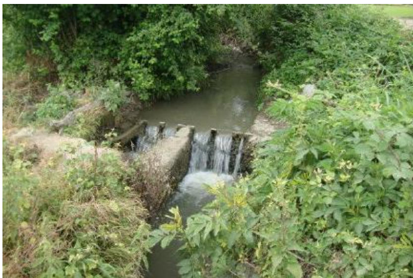
شکل ۱-۳. نمونه‌ای از دارکل چوبی برای تقسیم آب در رودخانه‌های مازندران.
