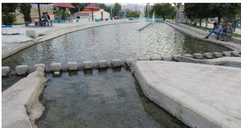
شکل ۱-۵. سنگ‌های تقسیم آب قنات ارونه اردستان، منسوب به پیش از اسلام است و تجدید سهم‌بندی آن را به خواجه نصیرالدین طوسی یا شیخ بهایی نسبت می‌دهند.
